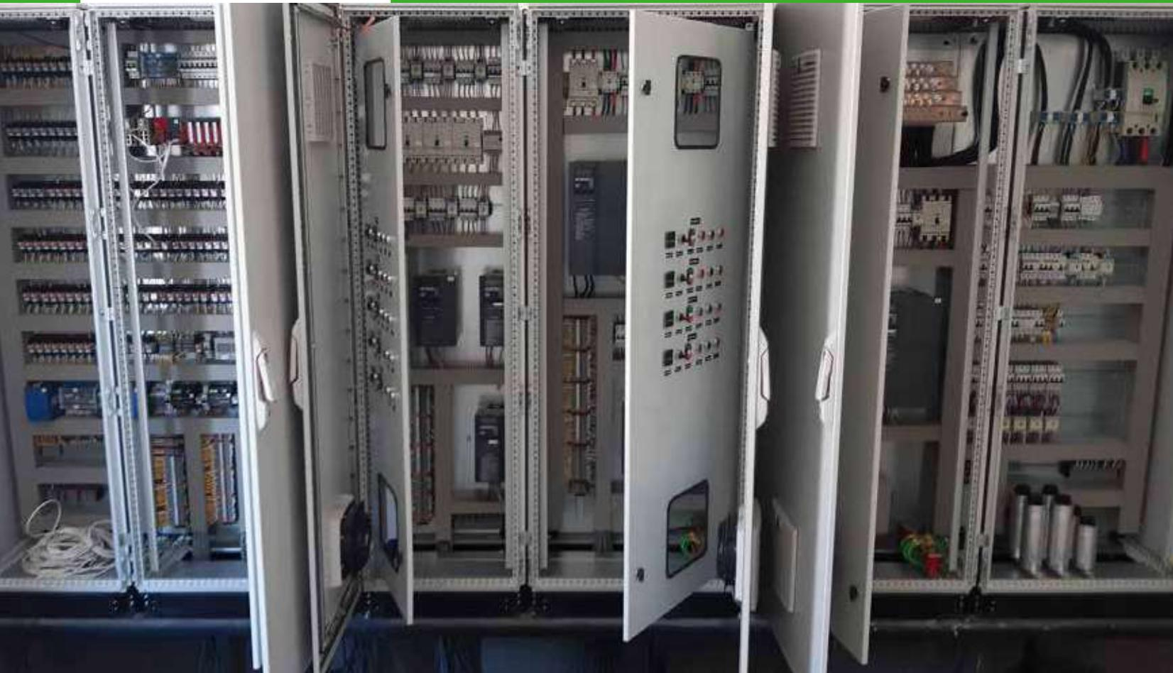
Tableros diseñados para controlar una o varias bombas de impulsión de agua (negras, duras, potables, etc.), esta impulsión puede realizarse bajo dos modos:
